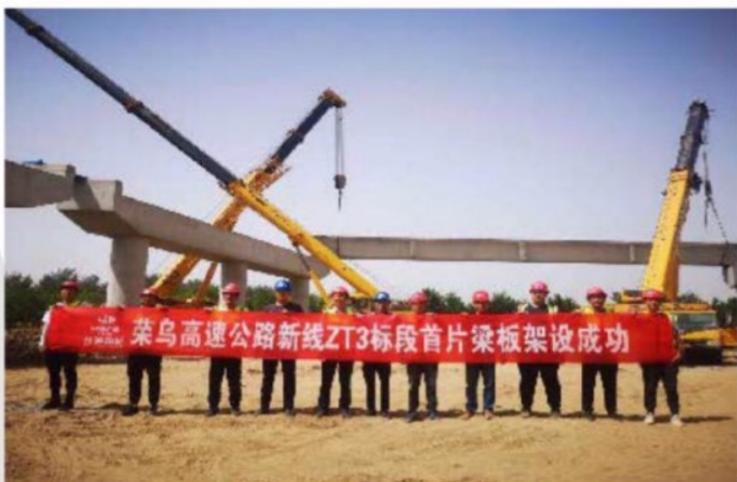
6月3日下午,随着一片长30米,重达100多吨的箱梁精准的架设在盖梁支座之上,宣告了荣乌高速 ZT3 标项目首片箱梁架设成功,标志着该项目桥梁建设由下部结构施工顺利转入梁板架设施工,工程建设顺利进入新的阶段。
